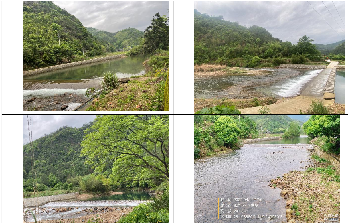
图 4.3-19 道太溪上已建部分水坝
