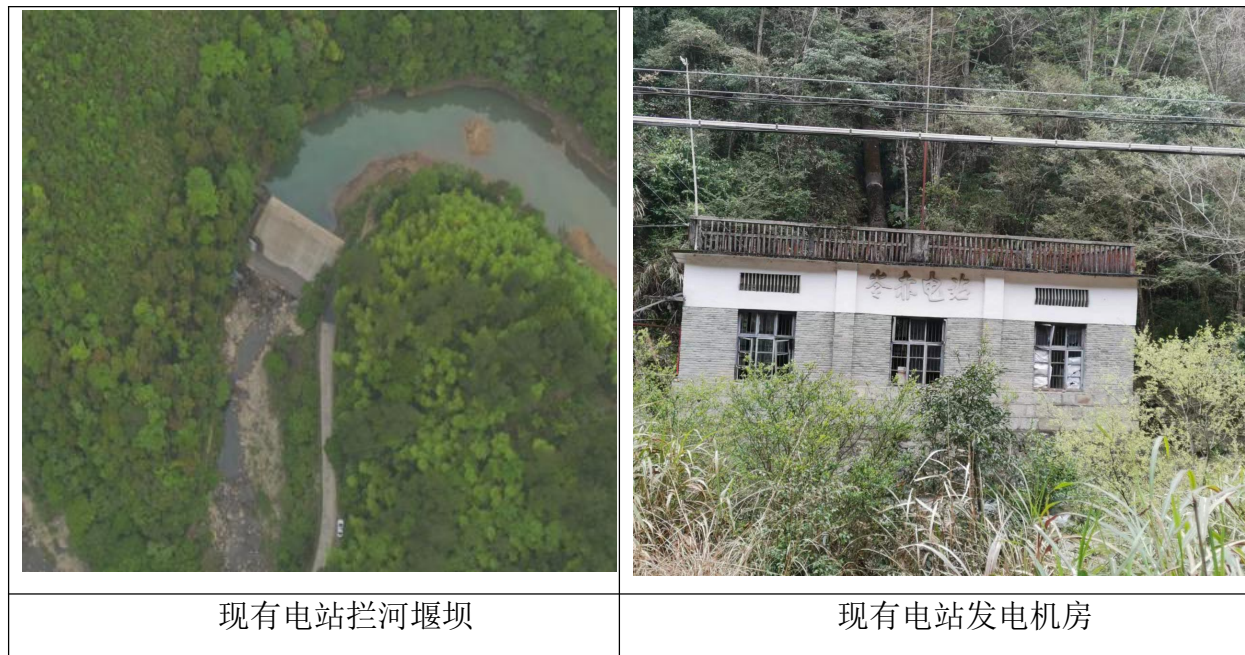
图 3.1-1 现有电站现状图片
