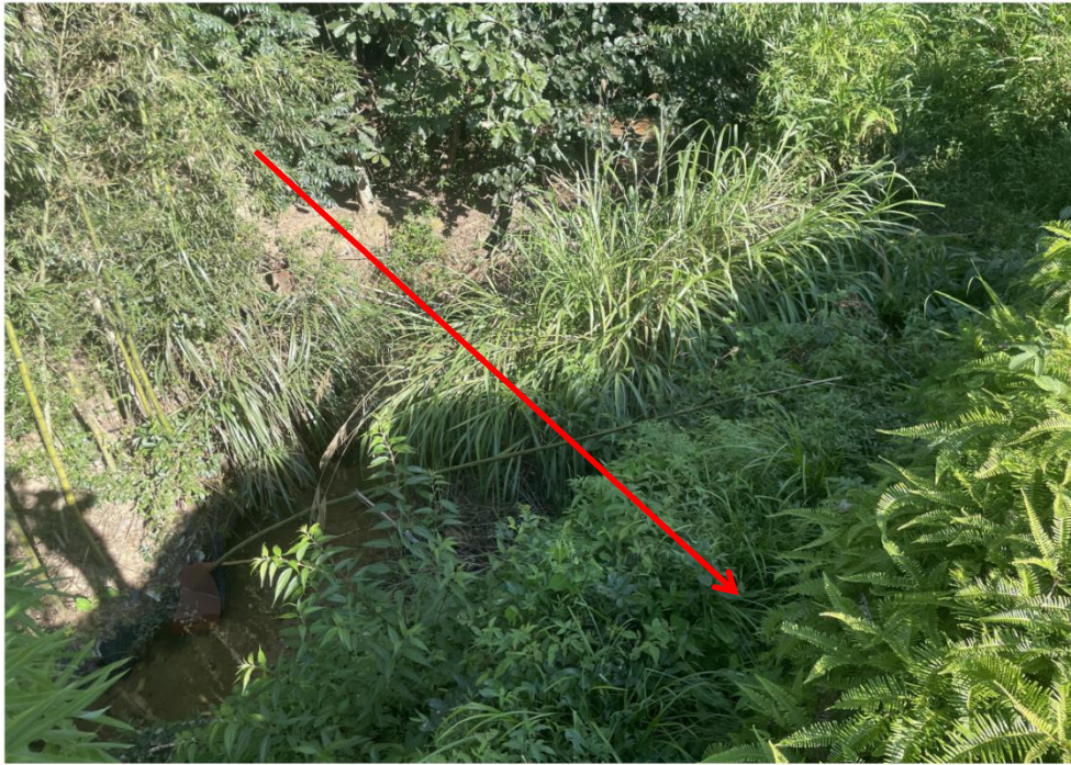
图 3.5-2 管线穿越沟渠（开挖、冲沟）
