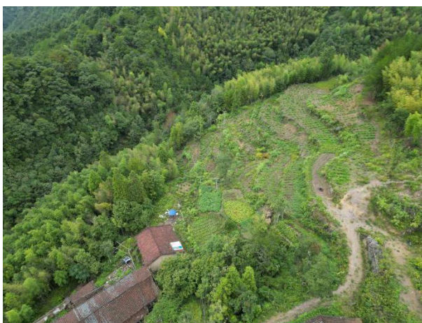
东绛山体定向钻入土点
