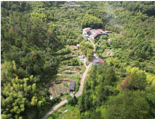
坝头山体定向钻入土点
