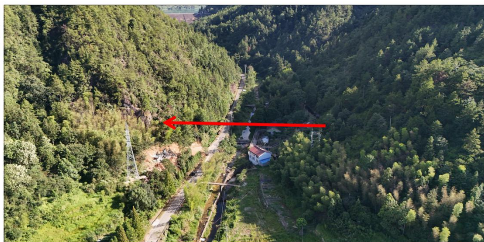
图 3.5-1 管线穿越沟渠（开挖、农灌沟）
